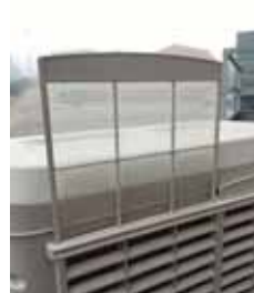
Filtro anti-insectos Insect filter Filtre d'insecte
